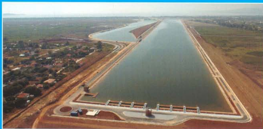
Ολυμπιακό Κωπηλατοδρόμιο Σχοινιά. Αεροφωτογραφία.
