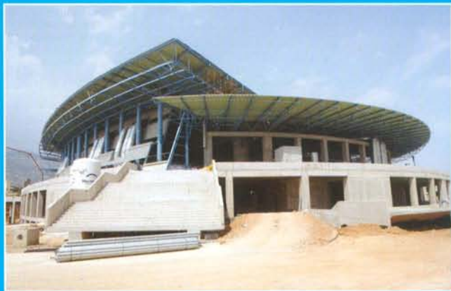
Έργα στο Ολυμπιακό Γυμναστήριο Άνω Λιοσίων.
