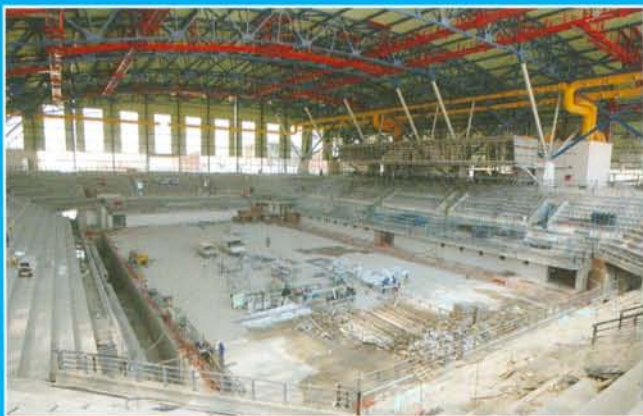
Έργα στο Ολυμπιακό Γυμναστήριο Γαλατσίου.
